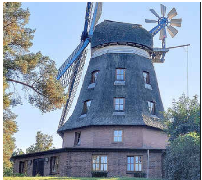
Die Banzkower Mühle präsentiert sich seit dem Sommer nackt, ohne Galerie-Geländer. Geplant ist, die Galerie zu erneuern und gastronomisch zu nutzen.
